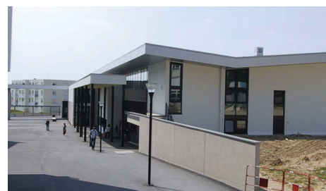
Lycée Oehmichen à Châlons-en-Champagne : le nouveau CDI au sein du pôle vie scolaire à l'entrée du lycée (2004)
