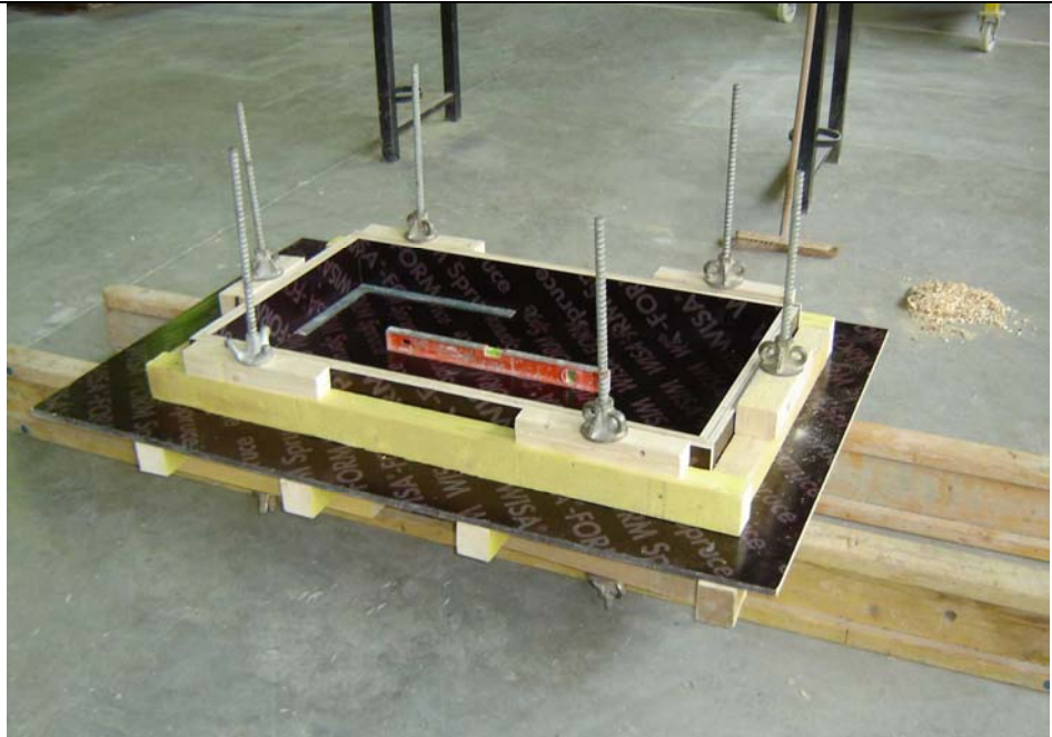
COFFRAGE D'UN ELEMENT PREFABRIQUE
