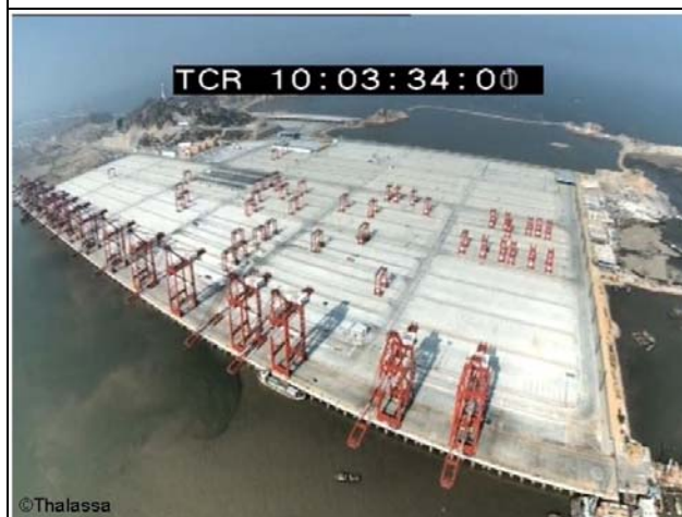
Les grues du terminal
