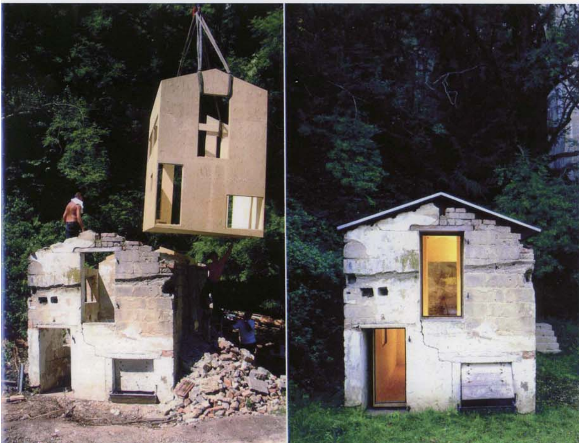
S(CH)AUSTALL , Projet de l'Agence FNP Architekten (à partir d'une construction de 1780, déconstruite partiellement pendant la Seconde Guerre mondiale en Allemagne), 2005.
