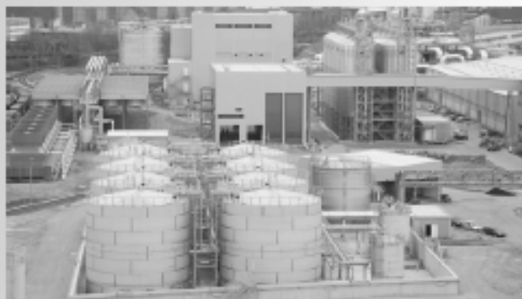
Südzucker Bioethanol, basé à Mannheim, Allemagne, produit de l'E85 à partir de leur récente installation (Fév. 2006) à Zeitz qui coûte 200 millions d'Euros. Elle produit 260 millions de litres de bioéthanol par an à partir de source à haute valeur protéinique, principalement le blé.
