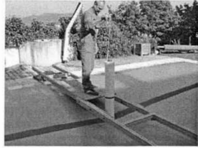
Test d'enfoncement vertical
