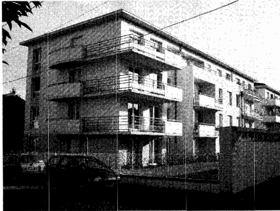
CONSTRUCTION D'UNE RESIDENCE DE 36 LOGEMENTS
